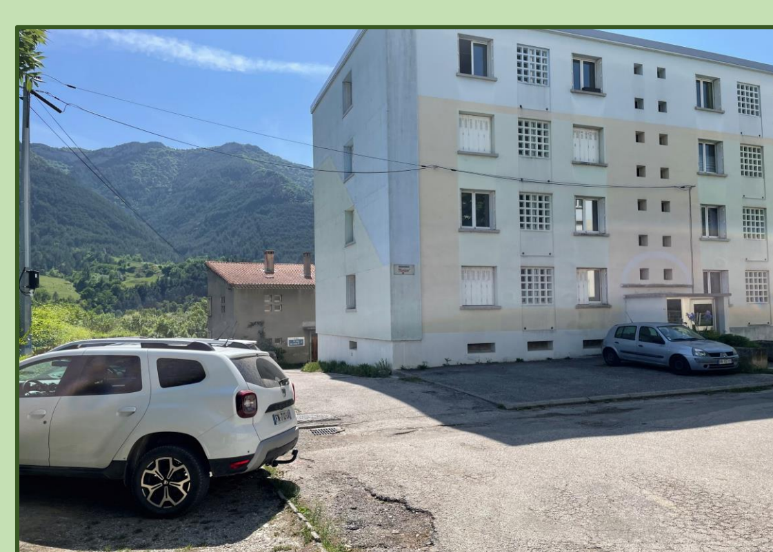
La route menant à l'école de musique (bâtiment en arrière-plan)
